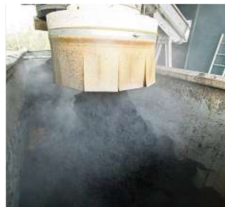
Ein Bild aus alten Zeiten. Der Schlammduft hatte für unangenehme Gerüche gesorgt. Jetzt wird der Dunst abgesaugt.
