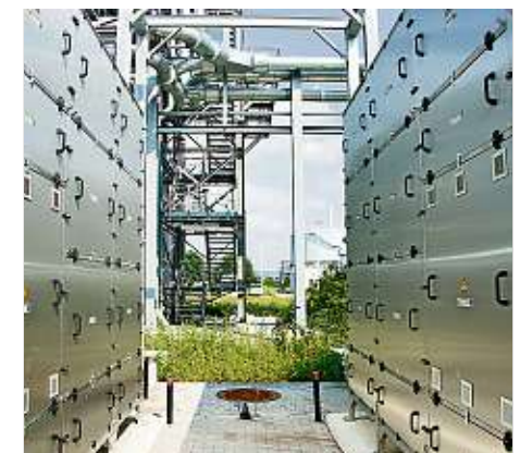
Das ist die Photoionisationsanlage. Bis zu 12.500 Kubikmeter Abluft können hier stündlich gereinigt werden.
