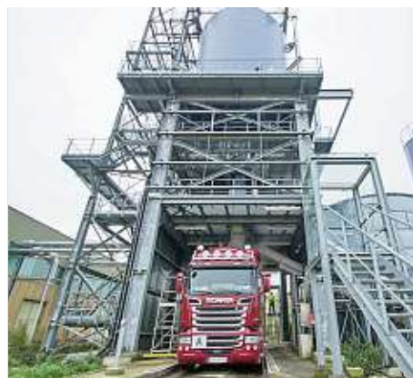
Das ist die Verladeanlage, von der der ausgefaulte Klärschlamm abtransportiert wird.
